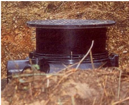
Die Anpassung an das endgültige Bodenniveau wird später mittels Feinjustierung durch Stellschrauben vorgenommen. Nachträgliche Bodenbelagsabsenkungen werden durch das höhenverstellbare Aufsatzstück automatisch ausgeglichen. Die Baugrube ist schichtweise zu verfüllen und zu verdichten.
