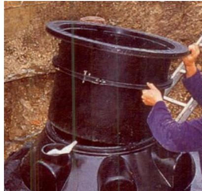
Einsetzen des höhenverstellbaren Aufsatzstückes. Den Klemmring vorher grob auf der gewünschten Einbauhöhe fixieren. Sollte es erforderlich sein, den Schacht zu kürzen, dann ist darauf zu achten, dass die Eintauchtiefe nicht zu gering wird. Die Abdeckplatte wird eingelegt, nachdem das Aufsatzstück in die Waagerechte gebracht wurde.
