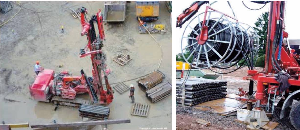
Abbildung 3: Bohrung [24] und Abteufen der Erdwärmesonde [25]
