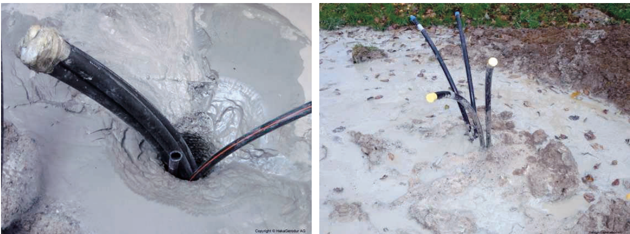
Abbildung 11: Abgeteufte Erdwärmesonde mit Injektionsrohr (links) [27] nach der Hinterfüllung (rechts) [28]
