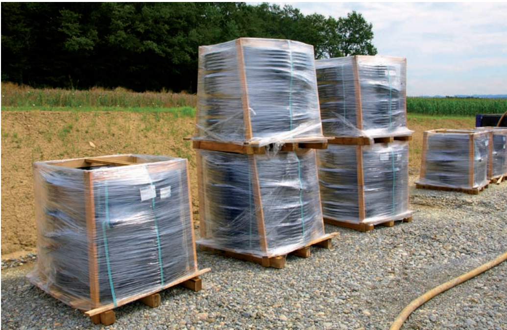
Abbildung 1: Transport auf Palette, Verpackung der Sonden mit Schutzverpackung [20]
