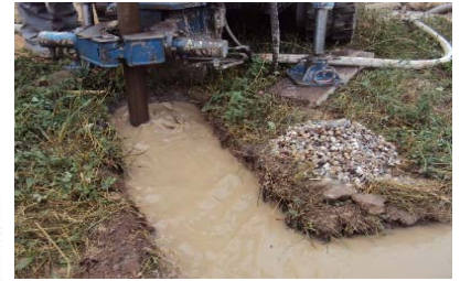
Bohrfortschritt und Sicherheit auf der Baustelle
